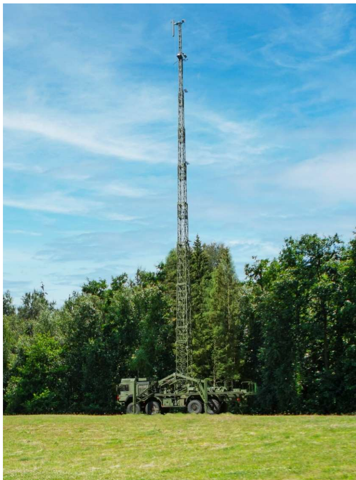
Fth 40/9 – Abspannfreier Antennenmast, Höhe 40 m
